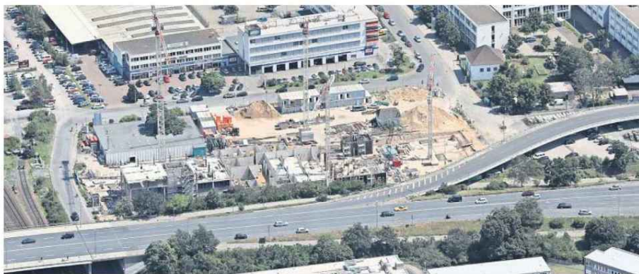
Berliner Brücke von oben: Dort entsteht das Projekt Berliner Haus.
