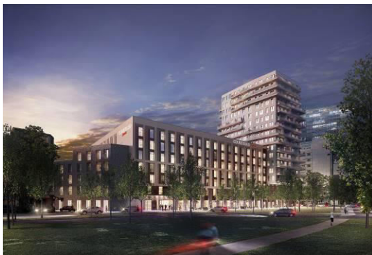
Das „KONRAD“ wird nach seiner Fertigstellung die Skyline von Hamburg mit seinem rund 60 Meter hohen Wohnturm bereichern.
